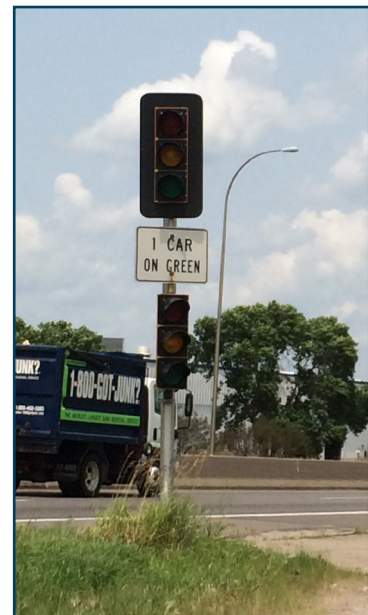
MnDOT Ramp Meter
